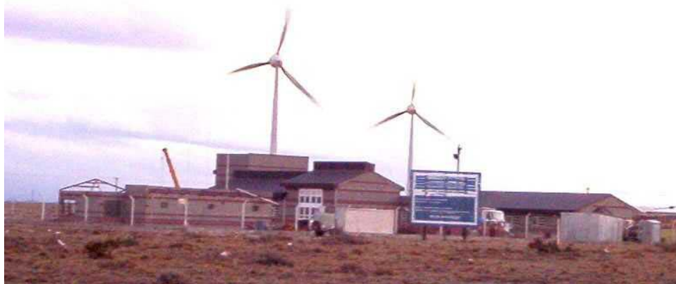
Figura 4.4 - Planta H2 Pico Truncado - en fase de construcción.
