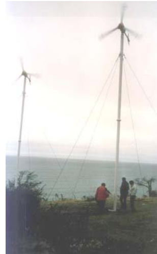
Figura 6.4 - (izq.) Detalle del SISMED 01-24, y (der.) vista de parque eólico (2xBergey1500-24) que suministra energía. Escuela Rural Agua Fresca - P.Arenas (Chile)
