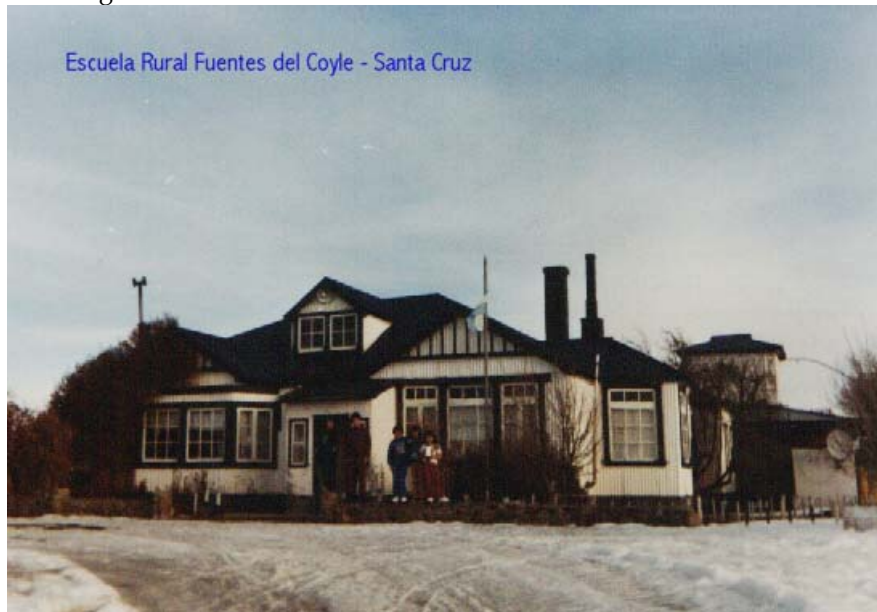
Figura 6.1a - Edificio (2002) de la Escuela Fuentes del Coyle
