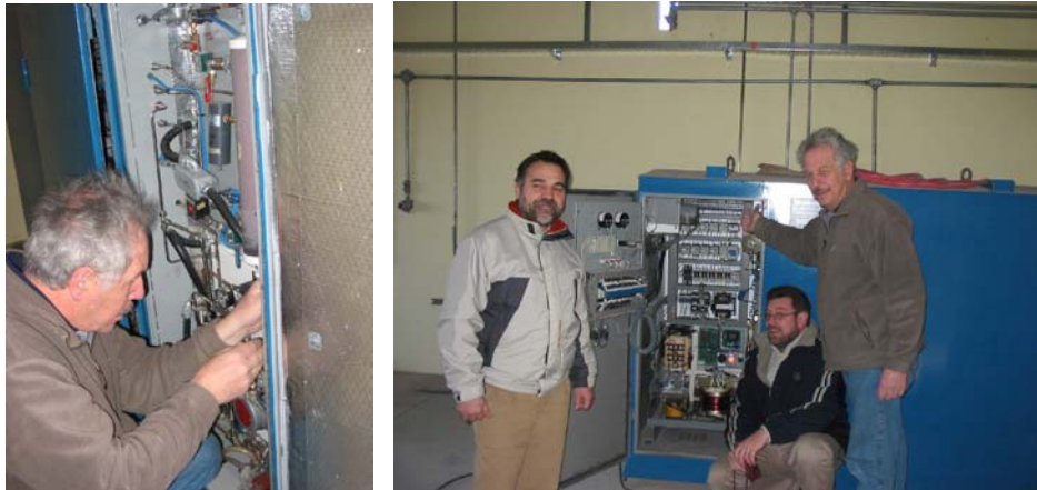
Figura 8.4 - Trabajos sobre electrolizador Stuart - 2005
