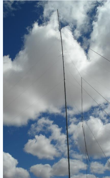
Fig. B Riendas sueltas Falta balizas
